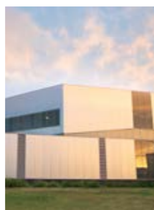
iseek Data Centre
