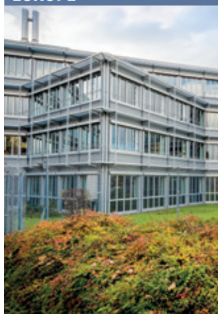
Kelsterbach Data Centre
